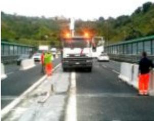
Proseguono i lavori di riqualificazione del **Raccordo Autostradale di Reggio Calabria** finalizzati all'innalzamento degli standard di sicurezza della circolazione mediante l'installazione di un nuovo impianto di barriere omologato secondo le più recenti normative vigenti, in sostituzione di un impianto esistente, destinato ad aumentare la sicurezza della circolazione.
